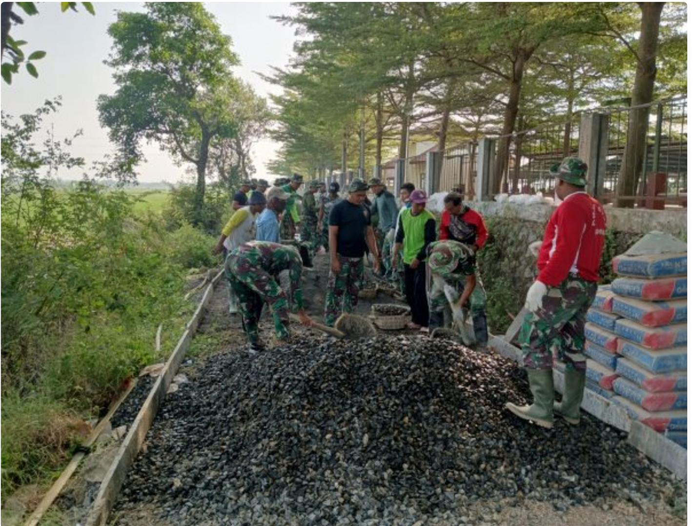
Foto istimewa ( Satgas tmmd reg 116 kebut pengecoran jalan
